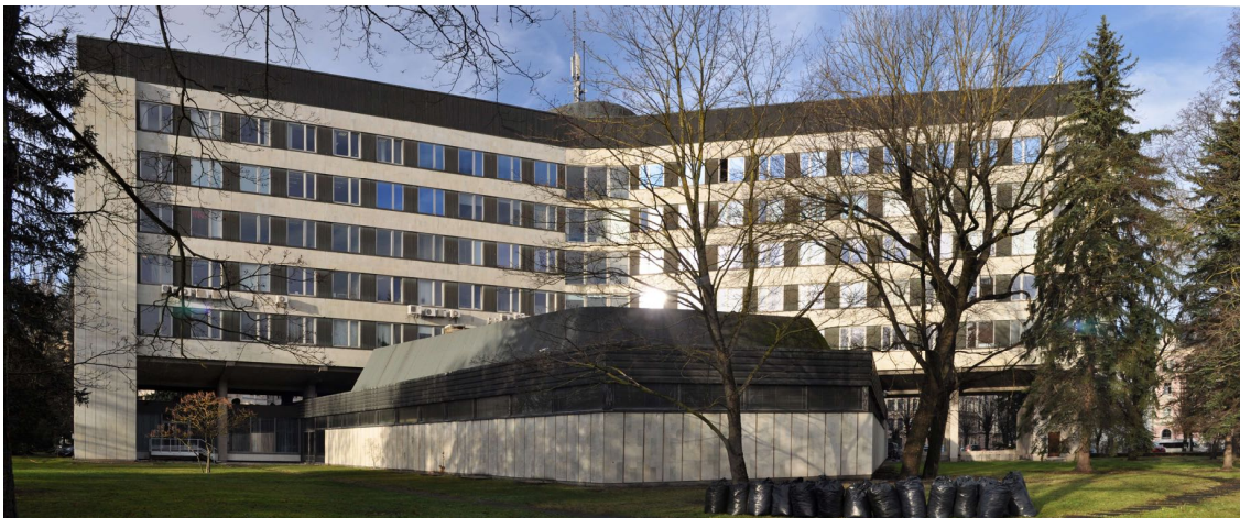
Att. 10. Parka (dienvidu) puses fasādes ar lielās konferenču zāles būvapjomu priekšplānā. 23.11.2020.
