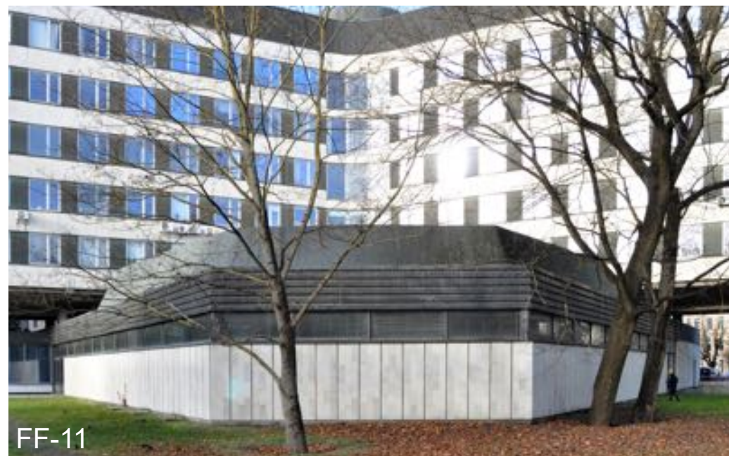
Konferenču zāles telpu grupas austrumu puses DA fasāde: DA un A fasādēm ļoti tuvu koki, kuru ietekmē bojāts jumta segums
