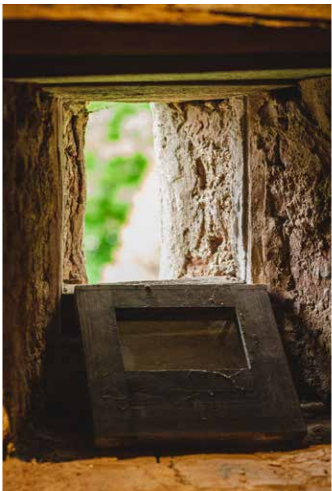
Šaujamlūkām uzstādīti aizvērtņi. Shutters are installed for gun-ports.
