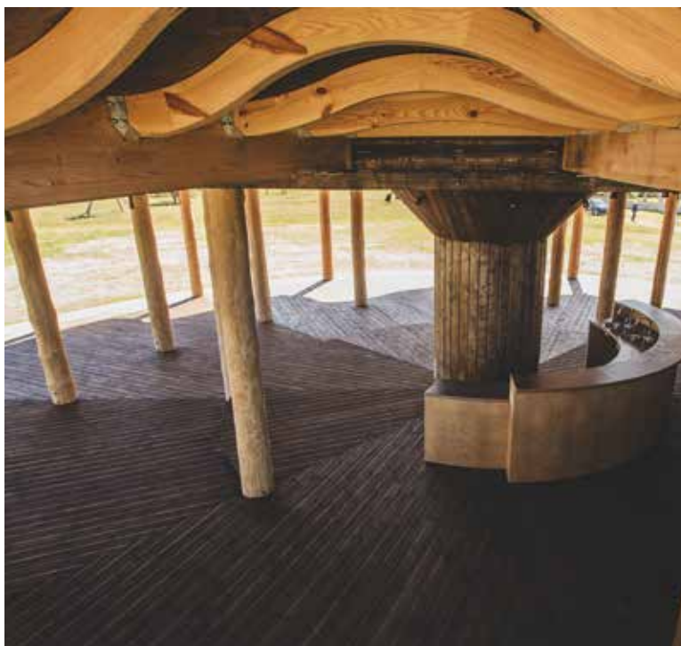
Izbūvēta dabas koncertzāle “Vējturu nams”. Ēkai ir divi stāvi, koka skaidu jumts, koka spāres un koka dēļu fasāde. Open-Air Concert Hall Vējturu nams is built. It has two floors, a wood shingle roof, wooden rafters and a wooden plank facade.
