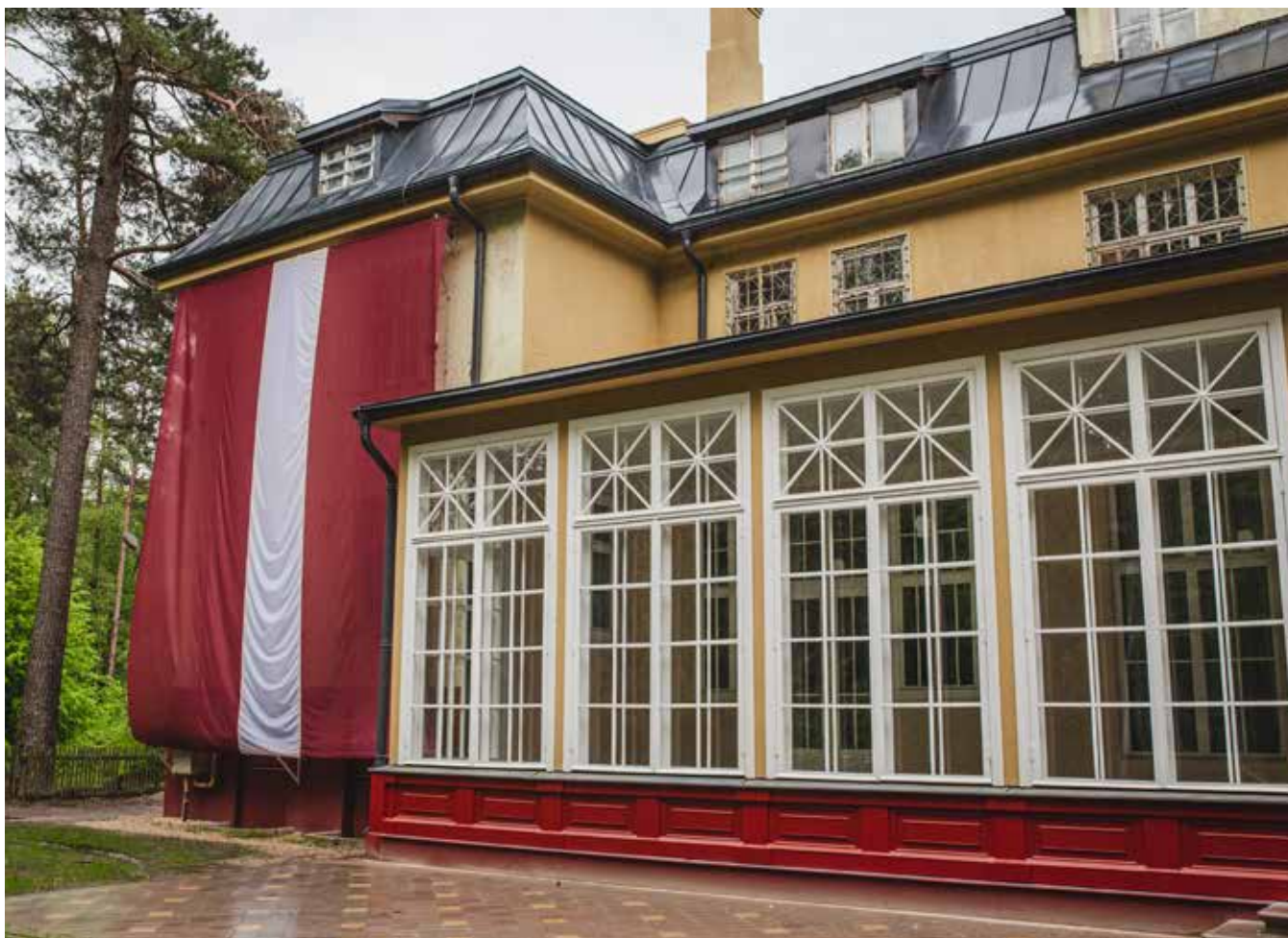
Atjaunota un izbūvēta ēkas pamatu horizontālā un vertikālā hidroizolācija. Horizontal and vertical waterproofing of the building's foundations is restored and constructed.
