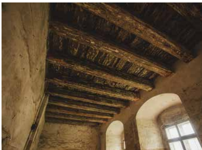
Daļēji restaurēts pils Dienvidu korpuss (jumts, šaujamlūkas un zibensaizsardzības sistēma, daļa no sijām). The southern wing of the castle is partially renovated (roof, gun-ports, part of the joist frames).
