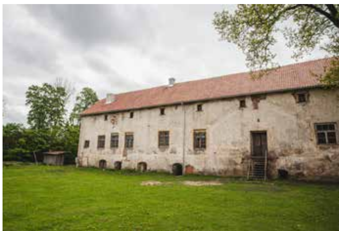
Daļēji restaurēts pils Dienvidu korpuss (jumts, šaujamlūkas un zibensaizsardzības sistēma, daļa no sijām). The southern wing of the castle is partially renovated (roof, gun-ports, part of the joist frames).
