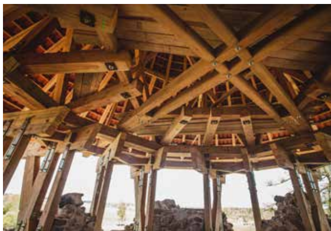
Tornim izbūvēta jauna jumta konstrukcija un dakstiņu jumts. A new roof structure and a tiled roof is built for the tower.
