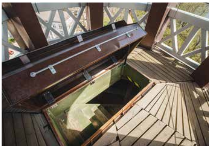
Izbūvētas jaunas kāpnes uz skatu torni. New staircase to the observation tower is built.
