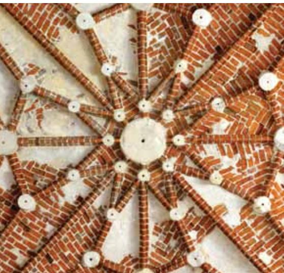
Pēc projekta veikta Cēsu viduslaiku pils rietumu tornja ārsienu konservācija, tornja jumtam atjaunots māla dakstiņu segums, veikta bojāto tornja jumta konstrukciju protezēšana, ierīkota tornja zibensaizsardzības sistēma, sakārtotas un labiekārtotas tā vītņu kāpnes, izbūvēta gājēju laipa un atjaunotas uzejas kāpnes. Mestra zālē veikta 16. gadsimta kieģeļu velves konservācija, telpā uzstādīti slēgi un ieklāta dēļu grīda, telpā virs zāles ierīkots sienās balstīts dēļu grīdas segums.
