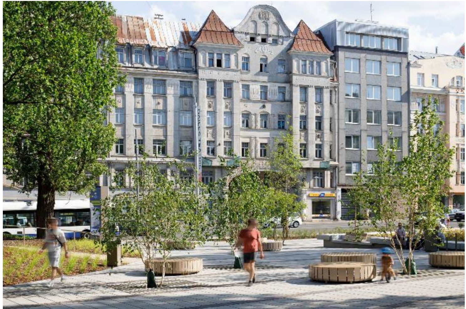
Latvijas Arhitektūras gada balva 2023 Lielā balva - SIA «MADE arhitekti», Dailes teātra priekšlaukums. Foto Ansis Starks
